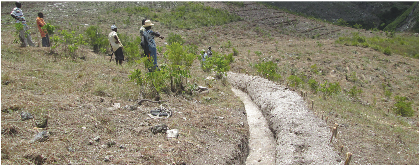
Canaux de contour / aménagement bassin versant.
